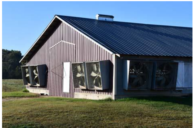
圖(二)、傳統 1990 年代 48 英吋斜壁風扇
