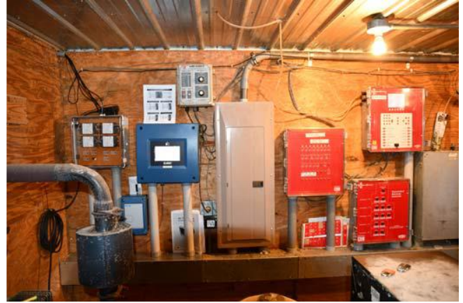
圖(六)、Choretime 環控系統與 Skov fan 介面(藍箱)、電表(左方)
