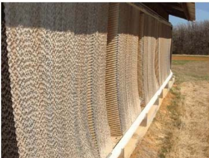
Figura 2. Daños en el panel debido a agua con pH elevado. Figura 3. Sulfato de calcio en la superficie del panel
