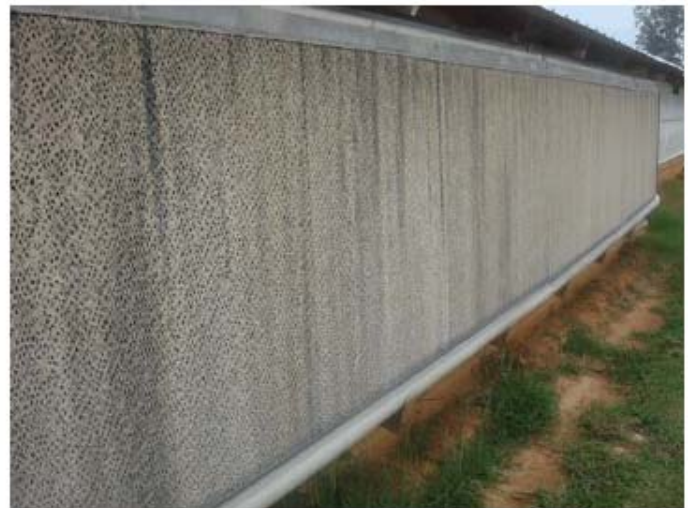
Figura 2. Daños en el panel debido a agua con pH elevado. Figura 3. Sulfato de calcio en la superficie del panel
