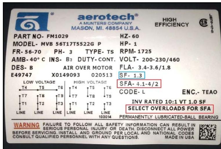
Figure 3. 1 HP fan motor nameplate.
