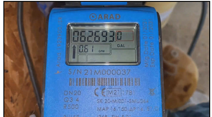
Figura 3. Medidor do lado da entrada do túnel.
