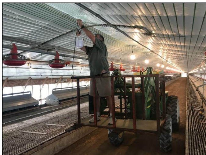
Figura 2. Instalacion de LEDs de 40 voltios
